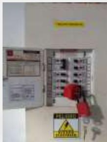
Es un método de Bloqueo de Energía que evita que el equipo se accione y ponga en riesgo la integridad de un colaborador
